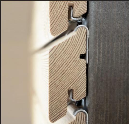
Der Fassadenverbinder **TIGA** garantiert eine einfache, schnelle und sichere Montage von offenen Fassadenverkleidungen aus Holz oder holzähnlichen Werkstoffen.
